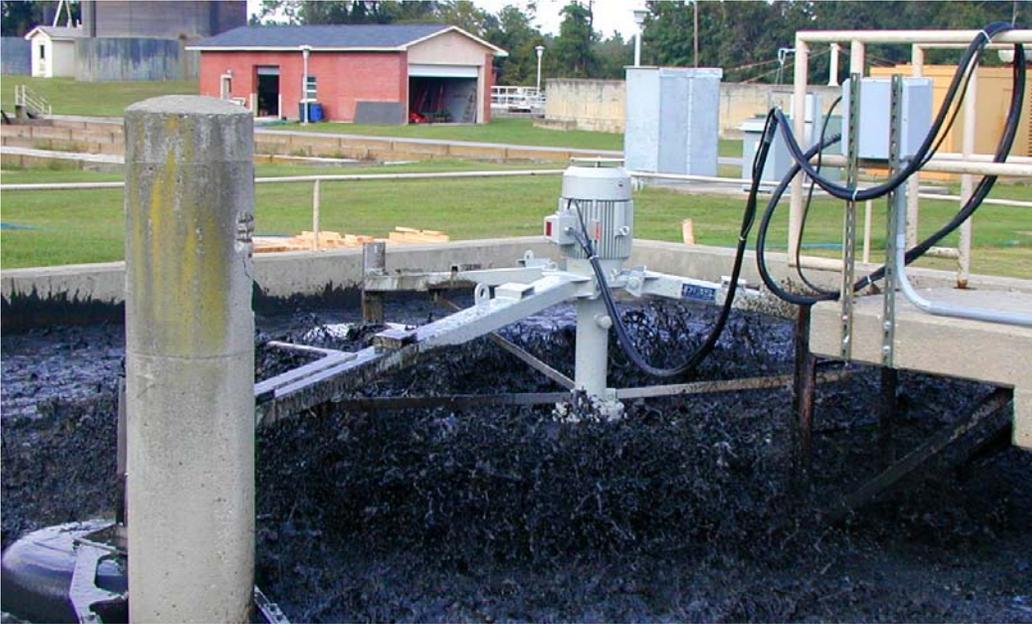
Los Aereadores Flotantes DBS son ideales para aplicaciones en lagunas y digestores aeróbicos. El diseño compacto del aereador NSA hace que estas unidades sean fáciles de armar e instalar. Todas las partes las partes que se mojan, incluyendo el rotor, la barra inferior de apoyo, y accesorios, están hechos de acero inoxidable para larga vida y confiabilidad.
